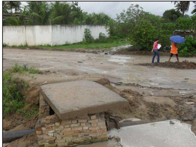
Figura 73 - Área crítica no Conjunto Feira VII, no acesso para o Aviário
