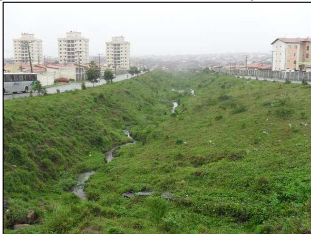
Figura 75 - Canal sem revestimento no Conjunto Feira IV
